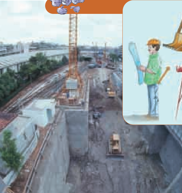
Ένας σταθμός κατασκευάζεται
