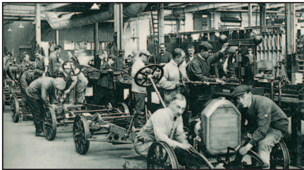
Εικ. 6.3α Σειρά συναρμολόγησης στο εργοστάσιο Ford.
