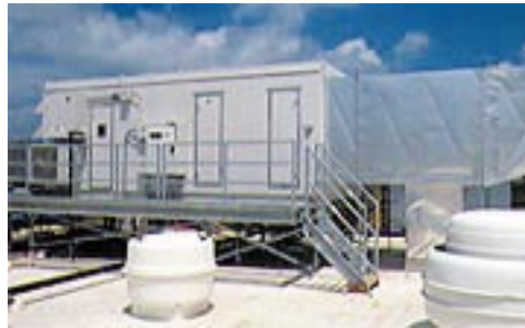
Εικόνα 1.17. Κεντρική μονάδα κλιματισμού αίθουσας χειρουργείου
