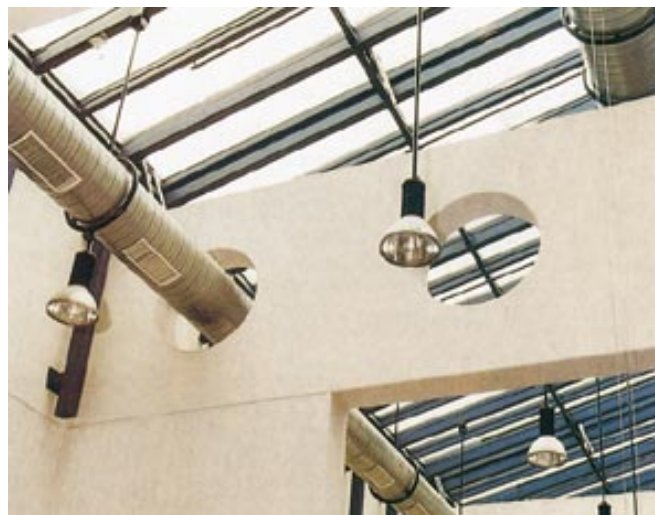
Εικόνα 1.18. Κλιματισμός με εμφανείς αεραγωγούς σε βιομηχανικό χώρο
