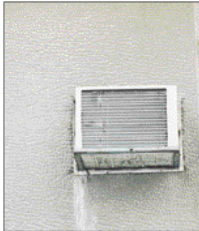
Εικόνα 1.7: Ενιαίου τύπου κλιματιστική μονάδα που τοποθετείται σε μια μεγάλη τρύπα στον τοίχο.
