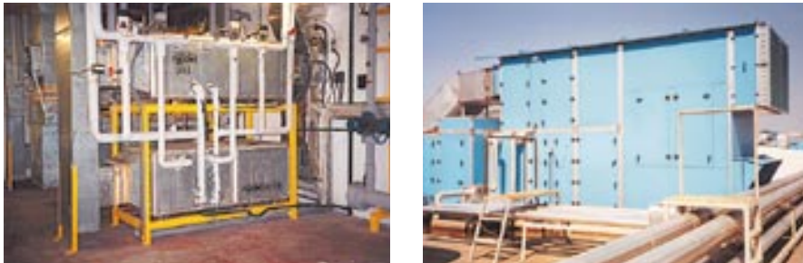
Εικόνα 1.9: Κεντρικές κλιματιστικές μονάδες (ΚΚΜ). Δυο μικρού μεγέθους ΚΚΜ (αριστερά) με είσοδο και παροχή 100% εξωτερικό αέρα και μεγάλου μεγέθους ΚΚΜ (δεξιά) με μείξη εξωτερικού αέρα και αέρα επιστροφής.
