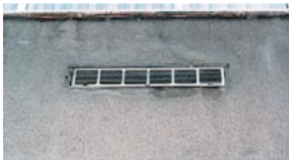
Εικόνα 1.6: Άνοιγμα με προστατευτικές περσίδες στην όψη κτιρίου για την είσοδο εξωτερικού αέρα στην εσωτερική κλιματιστική μονάδα.
