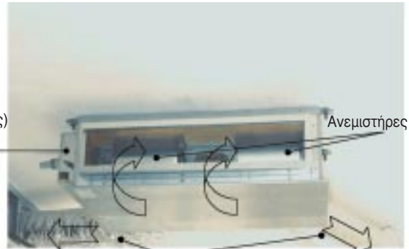
Εικόνα 1.4: Εσωτερική μονάδα ανεμιστήρα στοιχείου (fan coil) οροφής πριν τοποθετηθεί η ψευδοροφή. Η εισαγωγή του εσωτερικού αέρα στη μονάδα γίνεται με τον ανεμιστήρα (η συγκεκριμένη μονάδα έχει δυο ανεμιστήρες). Από τη πλευρά της εξόδου του κλιματισμένου αέρα συνδέονται εύκαμπτοι αεραγωγοί που οδηγούν τον αέρα στα στόμια σε διαφορετικά σημεία μέσα στον χώρο.
