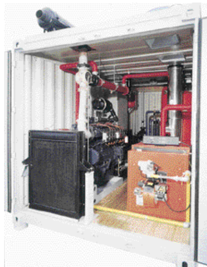
Εικόνα 1.11: Μονάδα συμπαραγωγής ηλεκτρικής ενέργειας – θερμότητας - ψύχους. Αριστερά εξωτερική μονάδα και δεξιά λεπτομέρεια από τον εσωτερικό χώρο της μονάδας.
