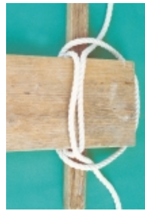
Εικόνα 7.17 (γ): Τελείωμα της σκαλωσιάς
